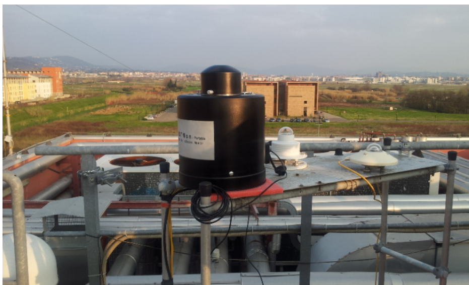
Figura 4 - Montaggio di un sensore durante la campagna LoNNe 2015 sul tetto dell'area di ricerca del CNR di Firenze
